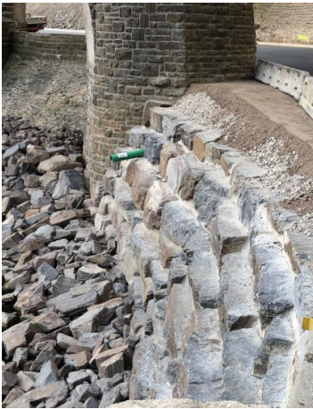
Bild 6b: Beispielfoto einer aufgesetzten Steinböschung
