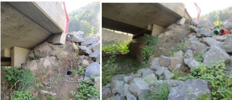
Bild 6 und 7: Diese Rohre sind zu sichern
