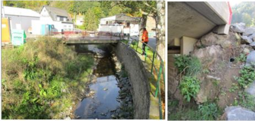
Bild 5 und 6a: Böschung, unbewehrter Beton am Widerlager
